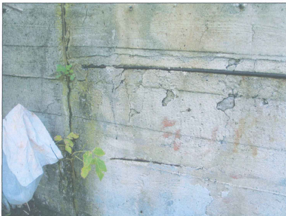
Fot.22. Szczelina dylatacyjna pomiędzy skrzydłem od strony ul. Spacerowej a korpusem przyczółka. Widoczne zbrojenie gładkie i ubytki przypowierzchniowej warstwy betonu. Zbyt mała grubość betonowej otuliny zbrojenia.
