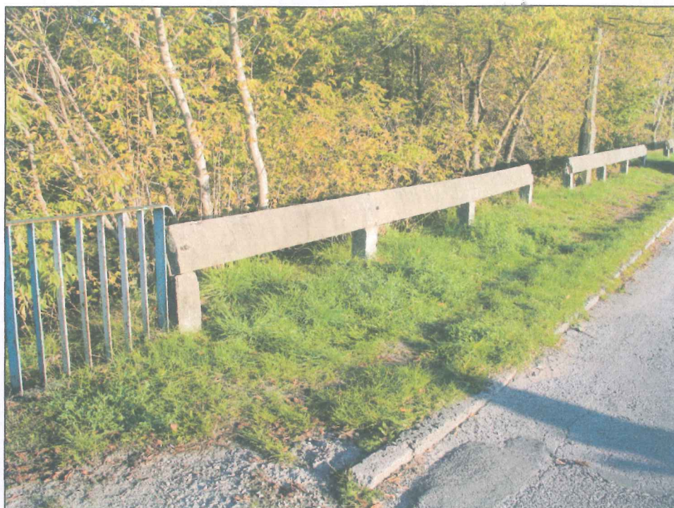
Fot. 13. Bariera żelbetowa na dojeździe od strony ulicy Spacerowej. Brak jednego przęsła bariery. Lokalna korozja zbrojenia.
