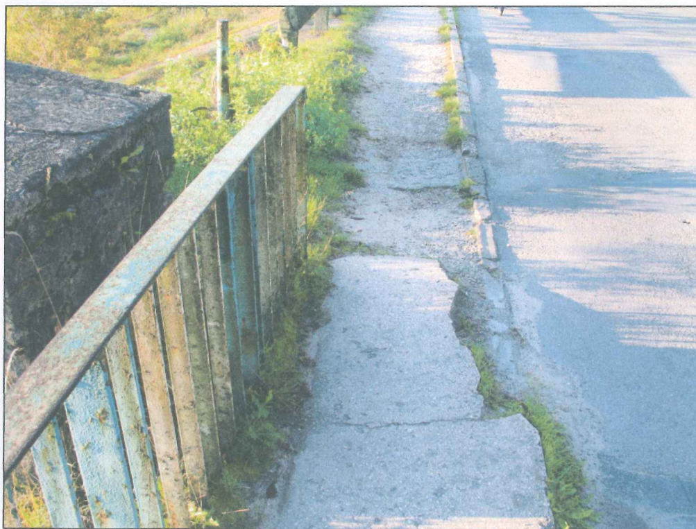
Fot. 10. Nawierzchnia chodnika od strony Wincentowa / górnej wody. Zanieczyszczenia z wegetacją roślinności. Spękania, ubytki i korozja betonu.
