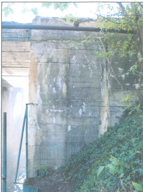
Fot. 19. Bok korpusu przyczółka od strony Wincentowa / dolnej wody. Liczne rysy, wykwyty i wyługowania wapienne. Wymienione uszkodzenia przyspieszają korozję betonu i stali i obniżają wytrzymałość betonu.
