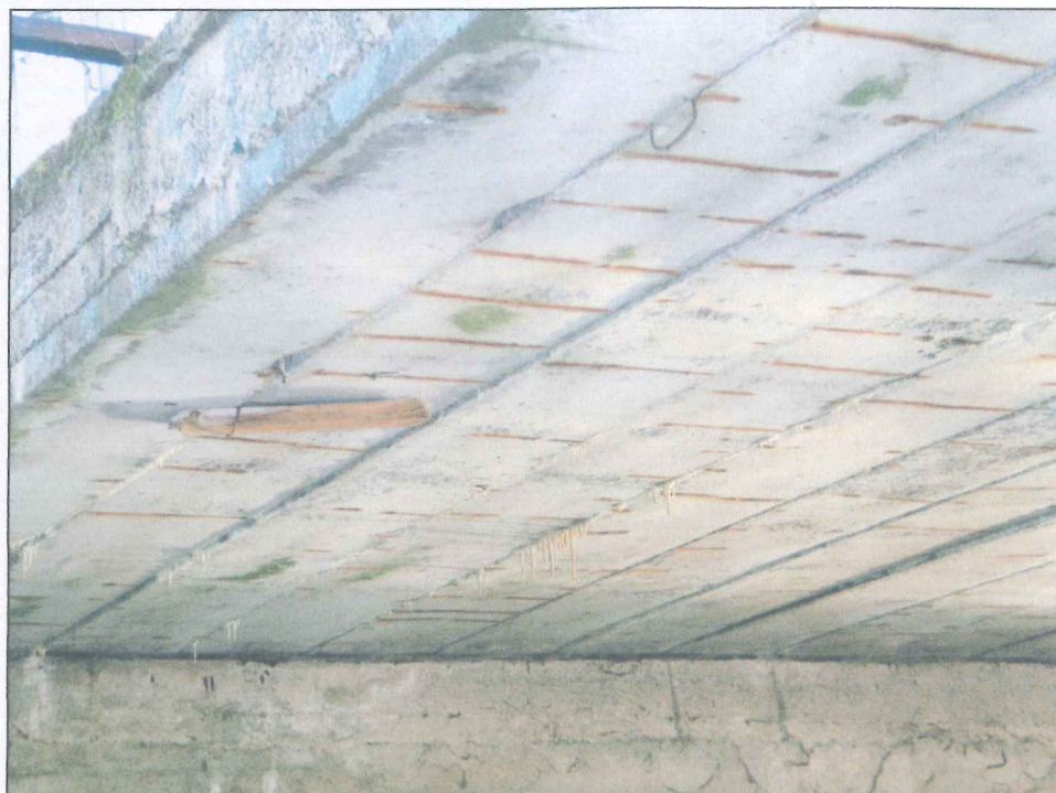
Fot. 15. Spód belek Kujan. Intensywne wykwyty i długie stalaktyty świadczą o wieloletniej penetracji wody przez konstrukcję na skutek awaryjnego stanu izolacji. Rdzawe wykwyty i korozja zbrojenia w miejscach zbyt cienkiej betonowej otuliny zbrojenia. Uszkodzenie występuje na całej powierzchni spodu ustroju nośnego.
