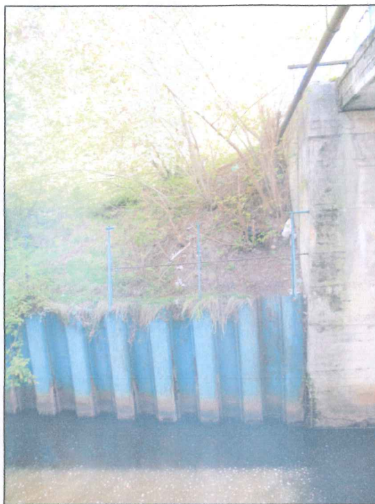
Fot. 7. Stożek nasypu od strony ulicy Spacerowej / dolnej wody. Zanieczyszczenia i intensywna wegetacja krzewów.
