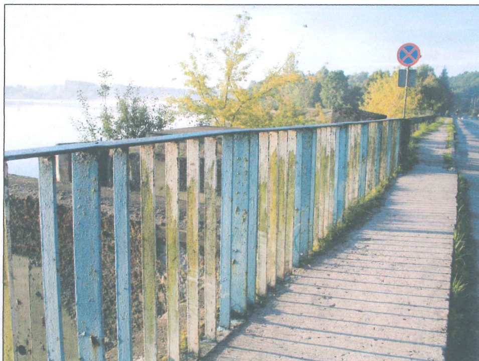
Fot. 12. Balustrada szczeblinkowa od strony górnej wody. Zbyt mała wysokość balustrady. Zanieczyszczenia, osady organiczne, ubytki i złuszczenia powłoki malarskiej oraz korozja elementów balustrady.
