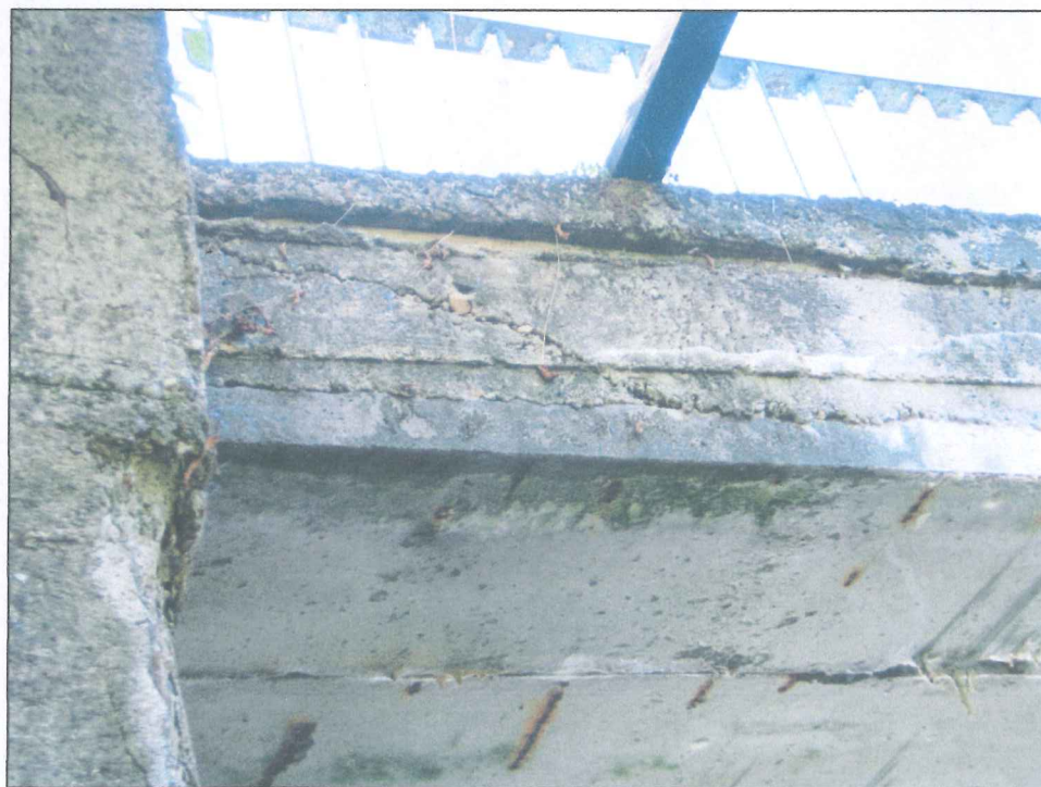
Fot. 16. Spód i bok ustroju nośnego. Spękania betonu na bocznej powierzchni ustroju. Rdzawe wykwyty i korozja strzemion belek Kujan. Zbyt mała grubość betonowej otuliny zbrojenia.
