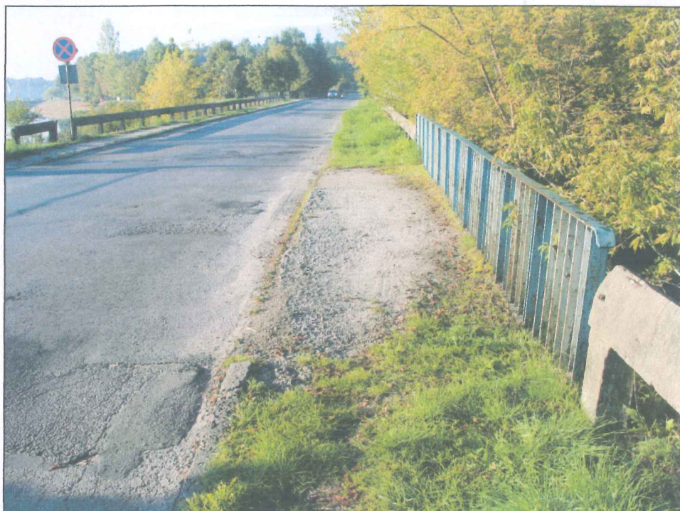
Fot. 11. Nawierzchnia chodnika od strony dolnej wody. Zanieczyszczenia z wegetacją roślinności. Korozja ogólna - zniszczenie struktury betonu.
