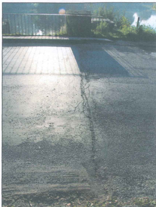
Fot. 17. Koniec ustroju nośnego od strony Wincentowa. Widoczne liczne pęknięcia poprzeczne nawierzchni i ślady napraw warstwy ścieralnej. Uszkodzenia świadczą o zasadności zastosowania urządzenia dylatacyjnego.
