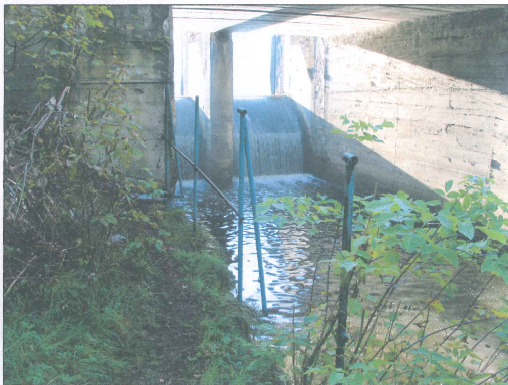
Fot. 20. Przestrzeń podobiektowa. Brak poręczy balustrady, która została odcięta przez złodziei.
