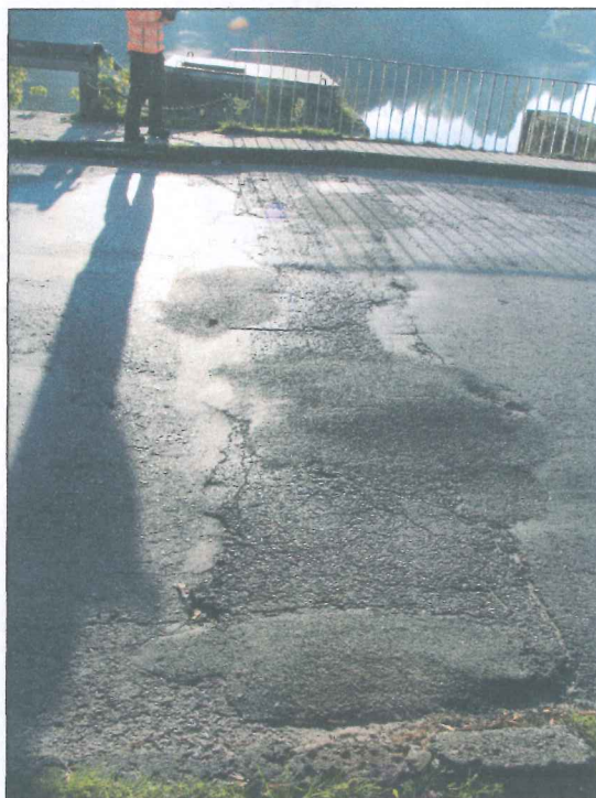
Fot. 8. Dojazd od strony ulicy Spacerowej. Widoczne ślady napraw jezdni oraz liczne spękania, deformacje i ubytki nawierzchni w obrębie skrzydeł. Stwierdzone uszkodzenia świadczą o braku płyt przejściowych oraz o konieczności zastosowania bitumicznych urządzeń dylatacyjnych.
