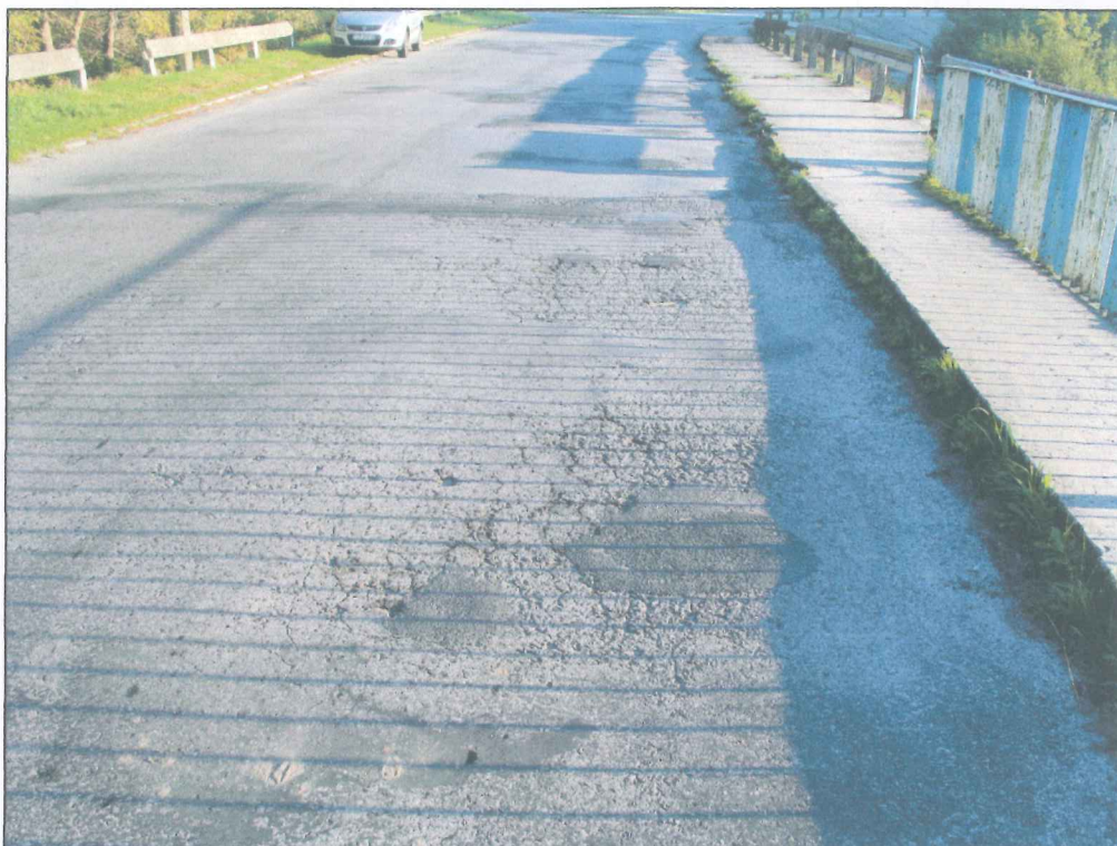
Fot. 9. Nawierzchnia jezdni na obiekcie. Zanieczyszczenia z wegetacją roślinności w obrębie krawężników. Spękania, ubytki i deformacje o różnej intensywności na całej powierzchni jezdni.
